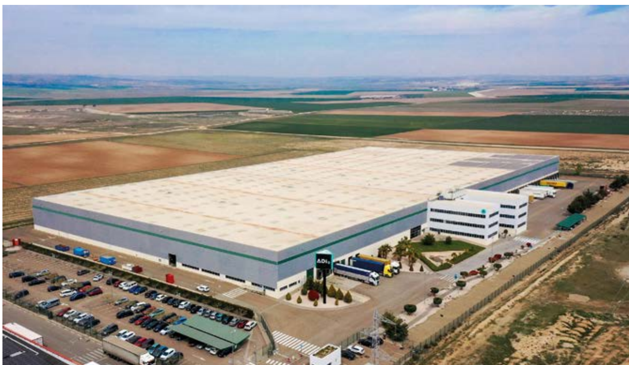
Vista aérea de las instalaciones en Zaragoza (España). PVPS recomendados válidos salvo error tipográfico, fotográfico o fin de existencias.
